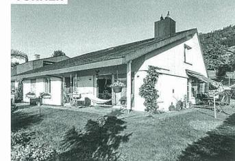
**Nachher:** Das ehemalige Satteldach wurde beim Umbau durch die Firma Strüby durch ein Vollgeschoss in Holz-Fertigelementbauweise ersetzt und so die Nutzfläche vergrössert.
