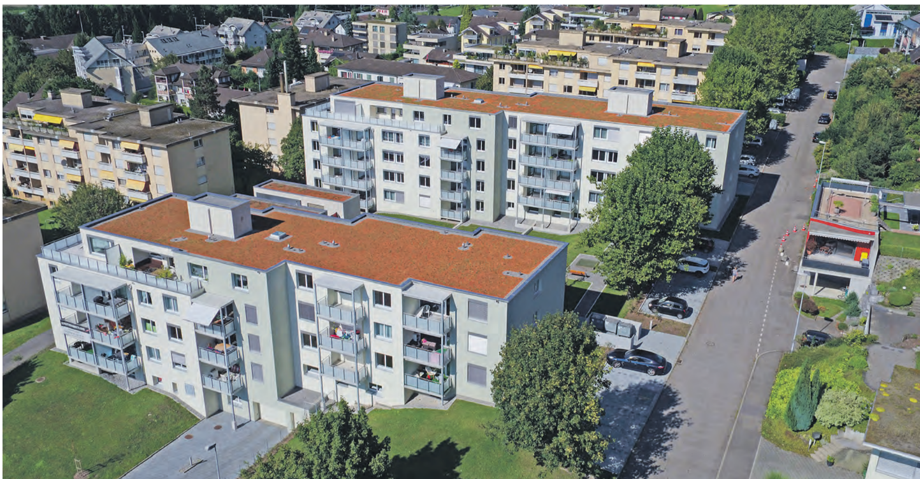
Kinderfreundlich und grosszügig – Überbauung Hagenmatt mit sanierten Wohnblocks aus Bauetappe 1 (Ansicht Hagenstrasse).
