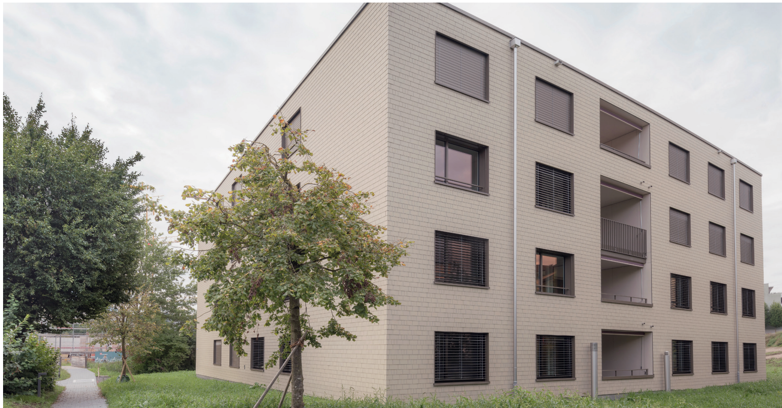
Die Wohnüberbauung «Riedbach-Park» im Grünen
