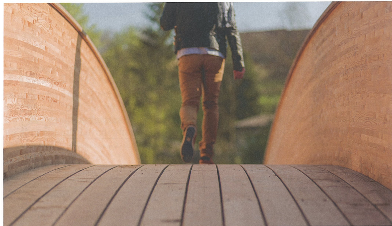
Die Überhöhung von 60 Zentimetern ist für das Auge gut sichtbar.
