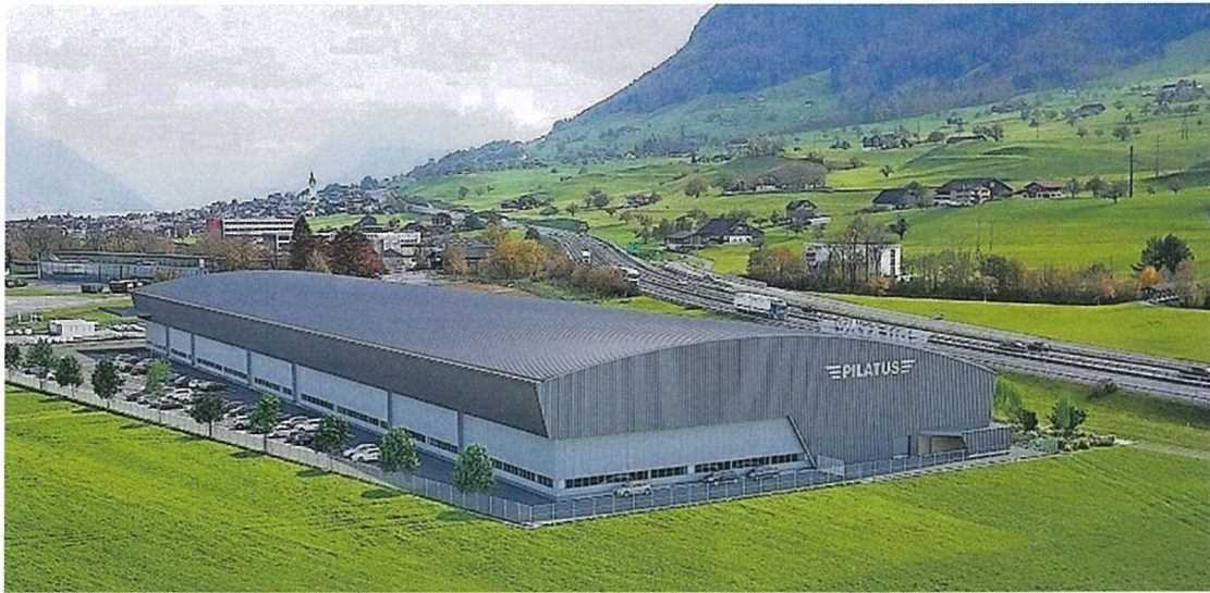
Die neue Halle der Pilatus Flugzeugwerke AG. Schweizer Holz und gigantische Dimensionen dominieren auch den neusten Bau der Flugzeugwerke.
