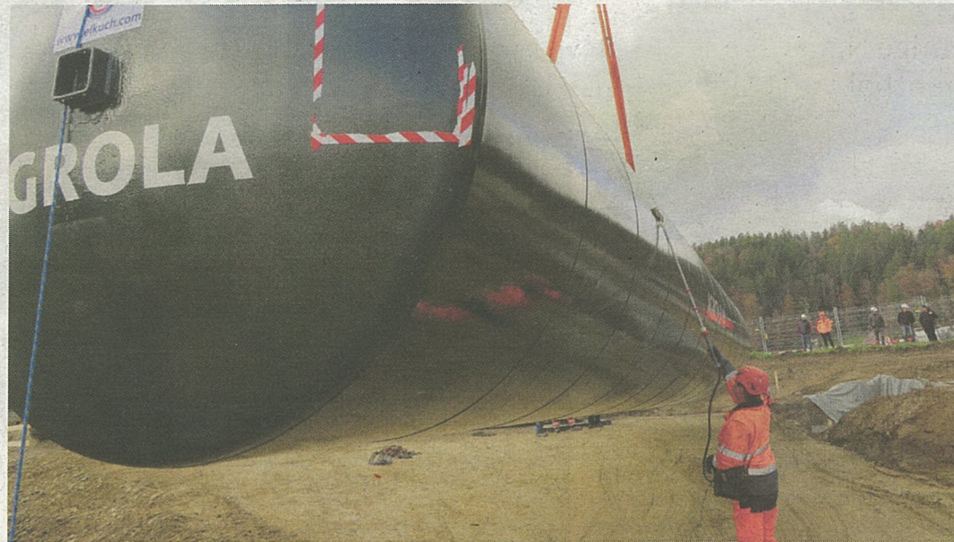
Millimeterarbeit mit der 25 Meter langen Spezial-Komposition. Der 28 Tonnen schwere Tank wird in die vorbereitete Baugrube gehievt.
