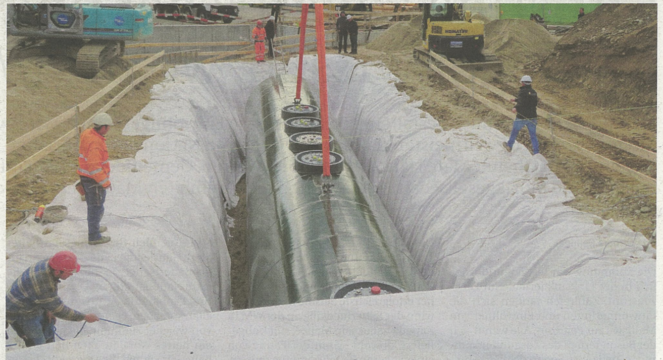
Der Treibstofftank liegt plangemäss und pannenfrei in der vorbereiteten Grube.
