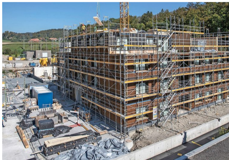
Jedes der zehn Mehrfamilienhäuser wird dank Holzelementen in knapp vier Wochen im Rohbau erstellt.
