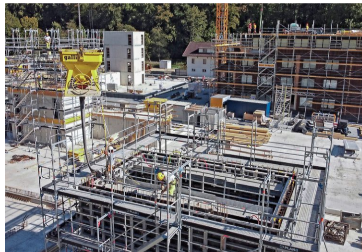
Die Wohnblocks werden zwischen der Heimiswilstrasse und dem Heimiswilbach erbaut.
