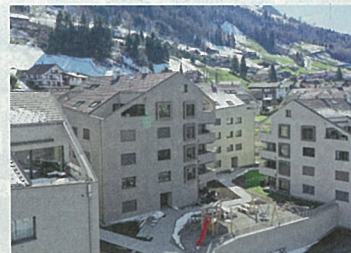
Im «Bergrausch» in Emmetten NW werden in diesen Tagen die letzten Wohnungen bezogen.
